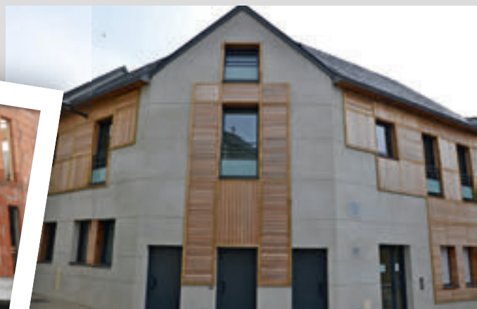
Cholet - Îlot des Marteaux 5 logements et des locaux associatifs en cours
